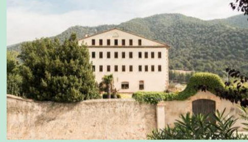
VISTA ACTUAL DEL MOLÍ DE CAL FERRERES
